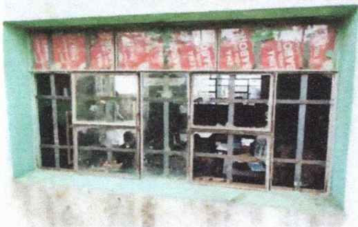
SUSTITUCION DE VIDRIOS EN EL AULA DE CUARTO PRIMARIA
