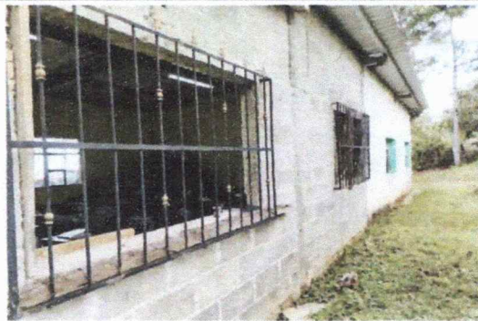
Foto 2: COLOCACION DE VENTANAS Y BALCONES EN LAS AULAS DE QUINTO Y SEXTO PRIMARIA
