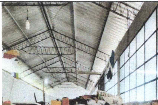
Foto 4: REPARACION DEL SISTEMA ENÉCTRICO EN EL MODULO DE PREPRIMARIA
